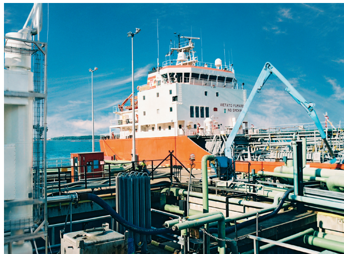
En CIRRUS® M500-enhet används för att återkondensera acetonångor under lastning av ett fartyg. Kondenserad aceton återförs till fartyget i flytande form och den förångade kvävgasen levereras till fartygets egna inertgassystem.
