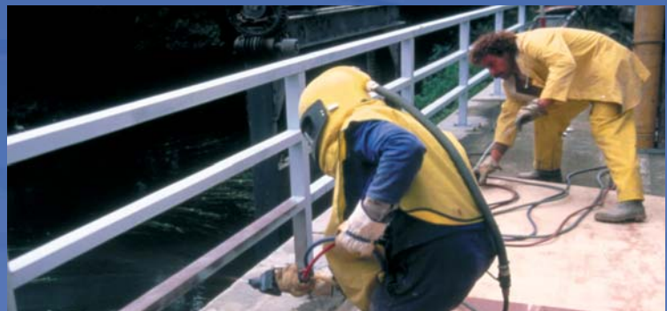
Proyección térmica con llama de un puente para protección de la corrosión
