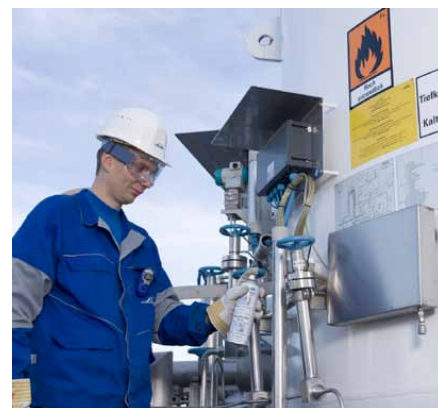
Prueba de fugas
