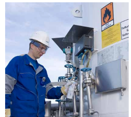
Prueba de fugas
