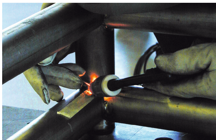
Fig. 3: structure tubulaire en Ti2 (technique de soudage de l'incox, Zoug)
