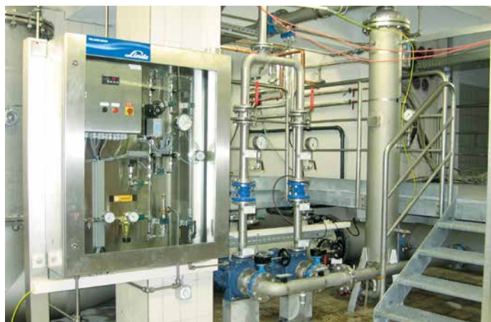
Réacteur SOLVOCARB® R avec unité de dosage de CO 2
