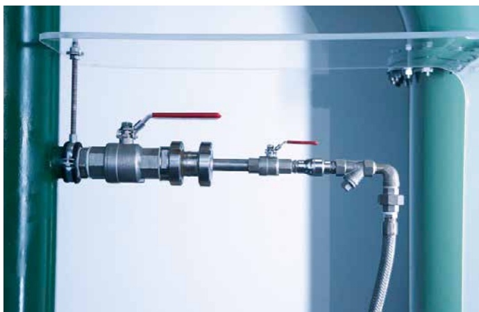
Dispositif d'injection SOLVOX® D
