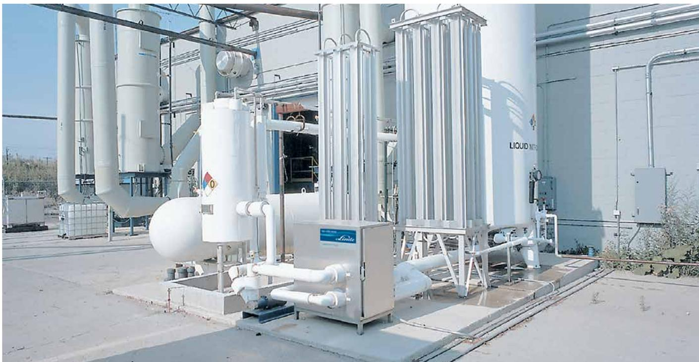
CUMULUS® PX20 chez GFS Chemicals aux Etats-Unis, un fournisseur de produits chimiques spéciaux. Le système est utilisé pour refroidir SYLTHERM® XLT au cours des réactions à base d'ammoniac. Avant d'installer le nouveau système, GFS utilisait des récipients d'ammoniac ouverts qu'elle refroidissait à la glace carbonique. Cette solution était inefficace et dangereuse puisque le  $\text{NH}_3$  est toxique. Aujourd'hui, la totalité du processus s'accomplit en circuit fermé.
