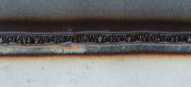
Cordon de soudure sans protection de la racine
