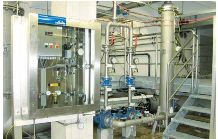
SOLVOCARB® R-Reaktor mit CO 2 -Dosiereinheit
