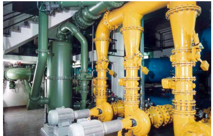
SOLVOX® R-Reaktor in einem Trinkwasserwerk
