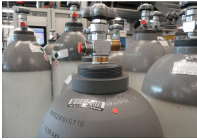
CO 2 -Flasche für gasförmige Entnahme (ohne Steigrohr)
