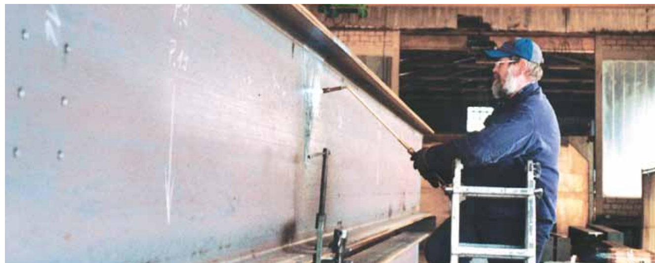
Bild 4.28 Flammrichten an einem Doppel-T-Träger
