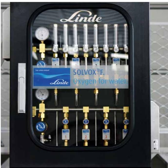
SOLVOX® F Schrank mit vier Abgängen für vier Versorgungsanschlüssen im Normal- und Notbetrieb
