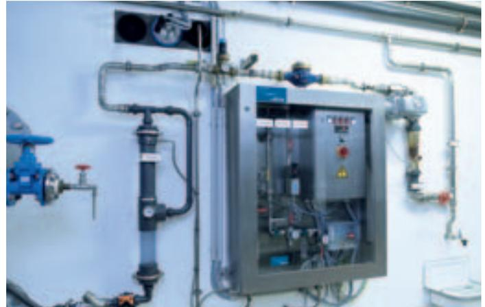
SOLVOCARB®-R-Reaktor mit CO<sub>2</sub>-Dosiereinheit
