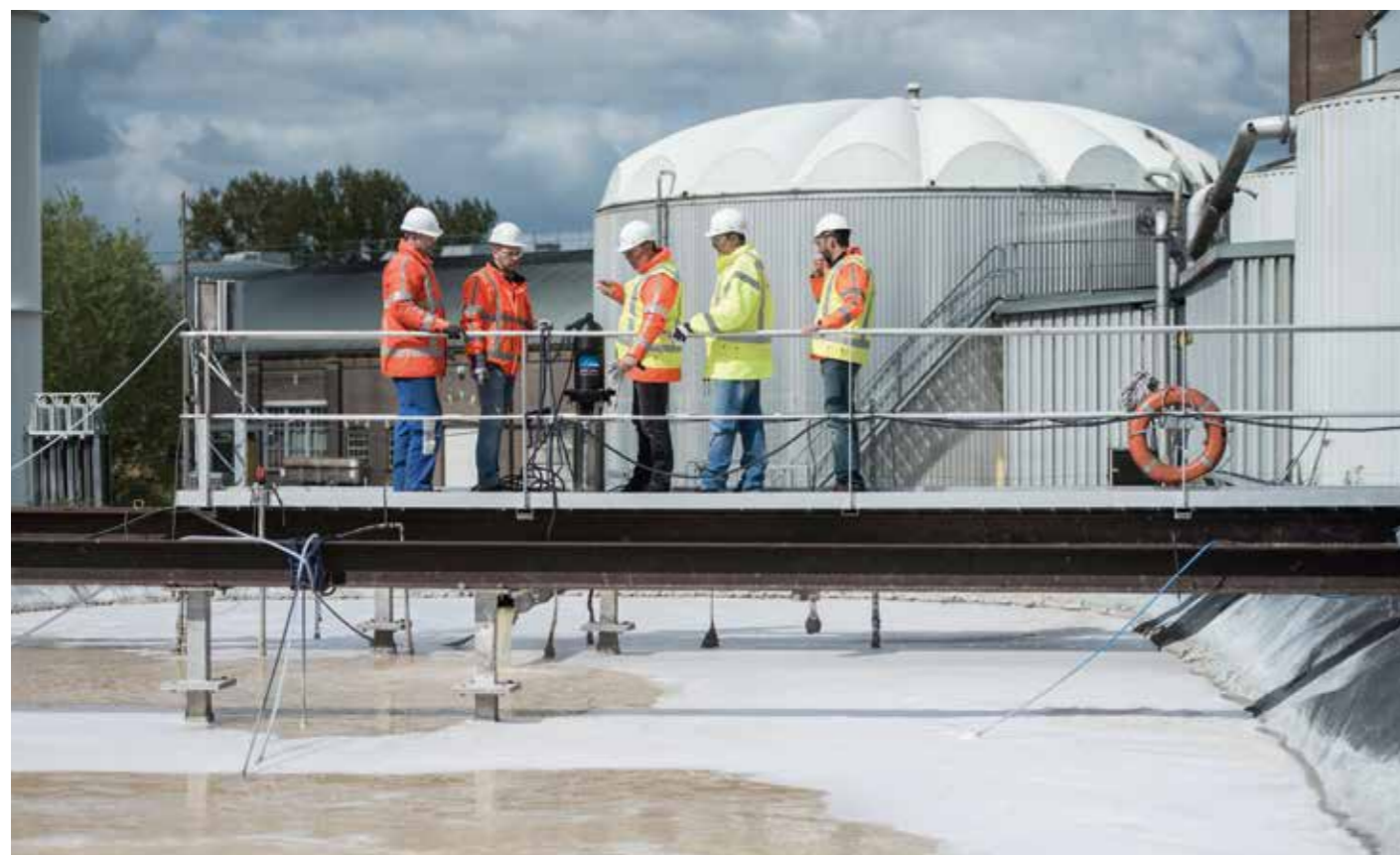
Installation von SOLVOX® mobile in einer industriellen Abwasseranlage in den Niederlanden.
