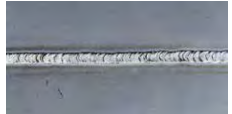
Schweissnaht mit Wurzelschutz
